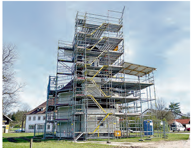
Das Wahrzeichen der Stadt, die denkmalgeschützte Nikolauskapelle, wird gerade aufwendig saniert.
